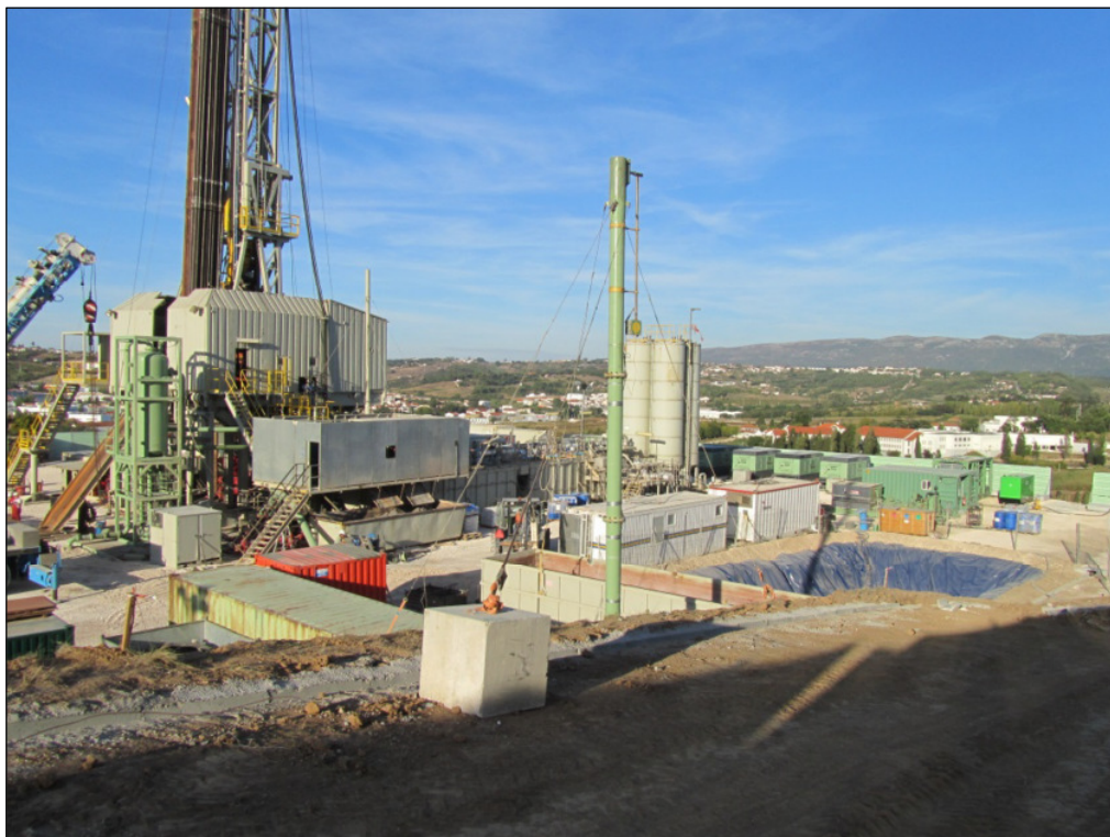
Figura 4 Sonda, torre do queimador da tocha (stack flare) e lagoa de lamas (350-500 m 3 )
